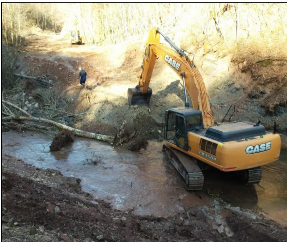
Sl. 3. Priprema za početak gradnje male hidroelektrane na rijeci Bjelava, opština Foča Izvor: https://impulsportal.net/index.php/zivotna-sredina/22856
