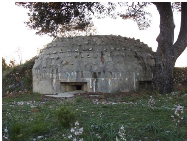
Slika 7. Veliki armirano-betonski bunker oznake C-19
