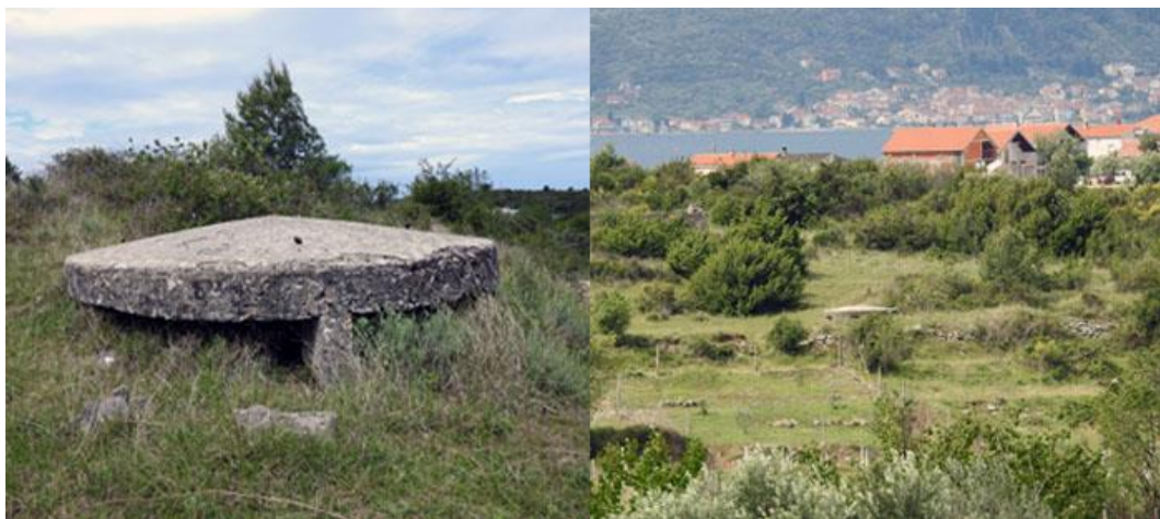
Slika 5. Laki armirano-betonski bunker oznake D-10 (lijevo) i isti bunker "stopljen" s okolicom (desno) Izvor: Autorska slika
