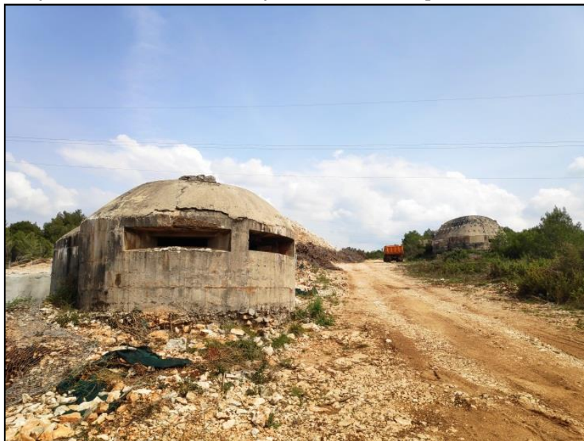
Slika 6. Srednji armirano-betonski bunker oznake E-31
