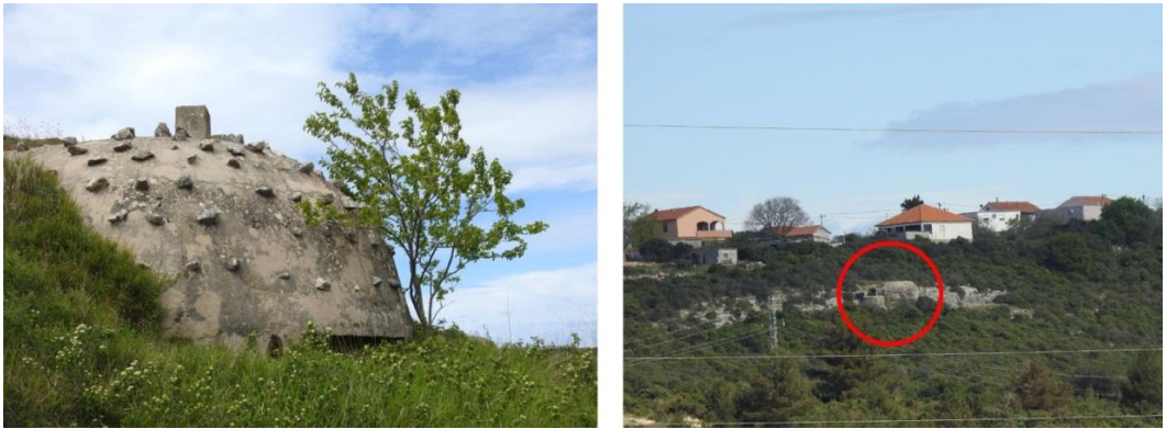
Slika 13. Primjeri kamuflaže; lijevo – šiljasto kamenje i nanos zemlje, desno – stapanje s kamenim okruženjem Izvor: Autorska slika
