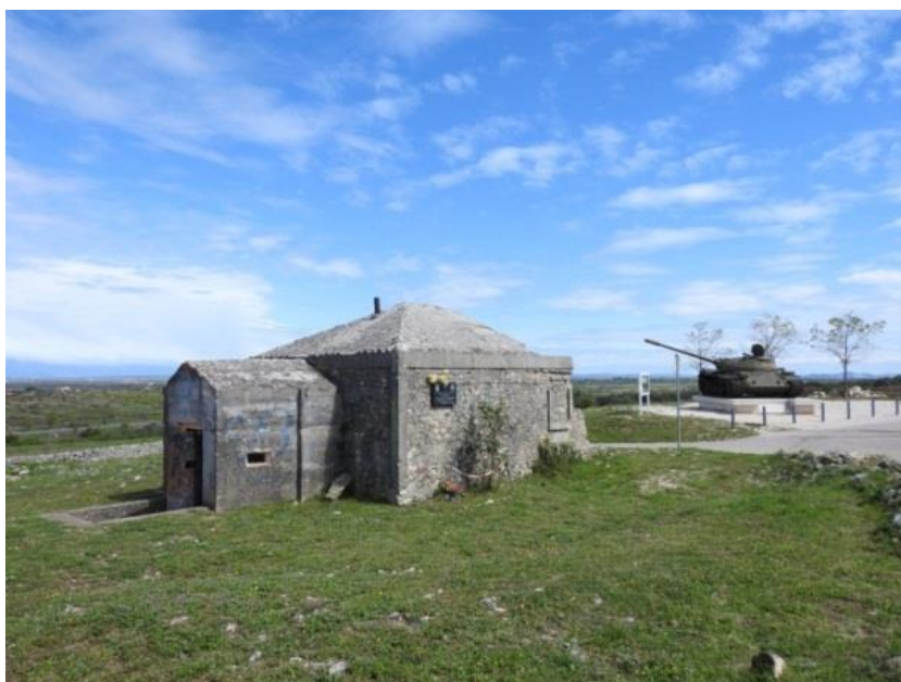
Slika 2. Kamuflirani bunker E-8 na Dračevcu i uništeni tenk (desno)
